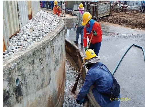
รูปที่ 23 การขุดลอกตะกอนจากรางระบายน้ำ ภายในพื้นที่ก่อสร้าง
