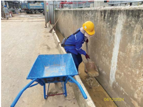
รูปที่ 23 การขุดลอกตะกอนจากรางระบายน้ำ ภายในพื้นที่ก่อสร้าง
